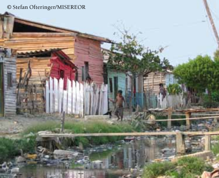
Armsiedlung in Kolumbien, Abwasserkanal
