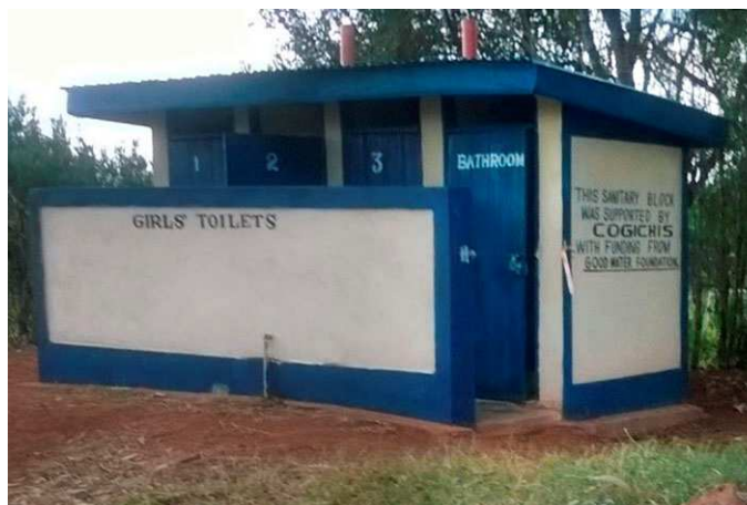
Block der Mädchentoiletten mit Waschraum © SOLWODI
