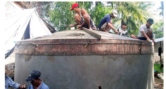
Bau eines Regenwassersammeltanks im Delta © arche noVa
