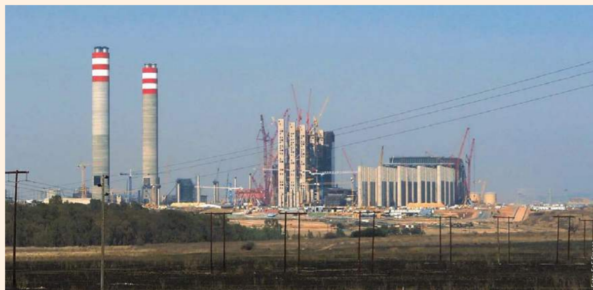
Die Kohlekraftwerke Kusile und Medupi entstehen mit Hilfe der KfW IPEX-Bank. Sie werden nach Fertigstellung die größten Kohlekraftwerke Südafrikas sein.
