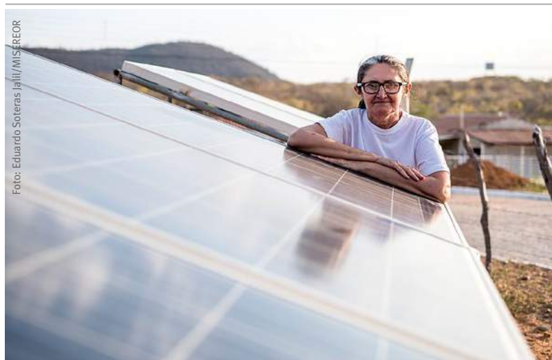
Kleine Photovoltaik-Freiflächenanlage in Acuaúã im Nordosten Brasiliens
