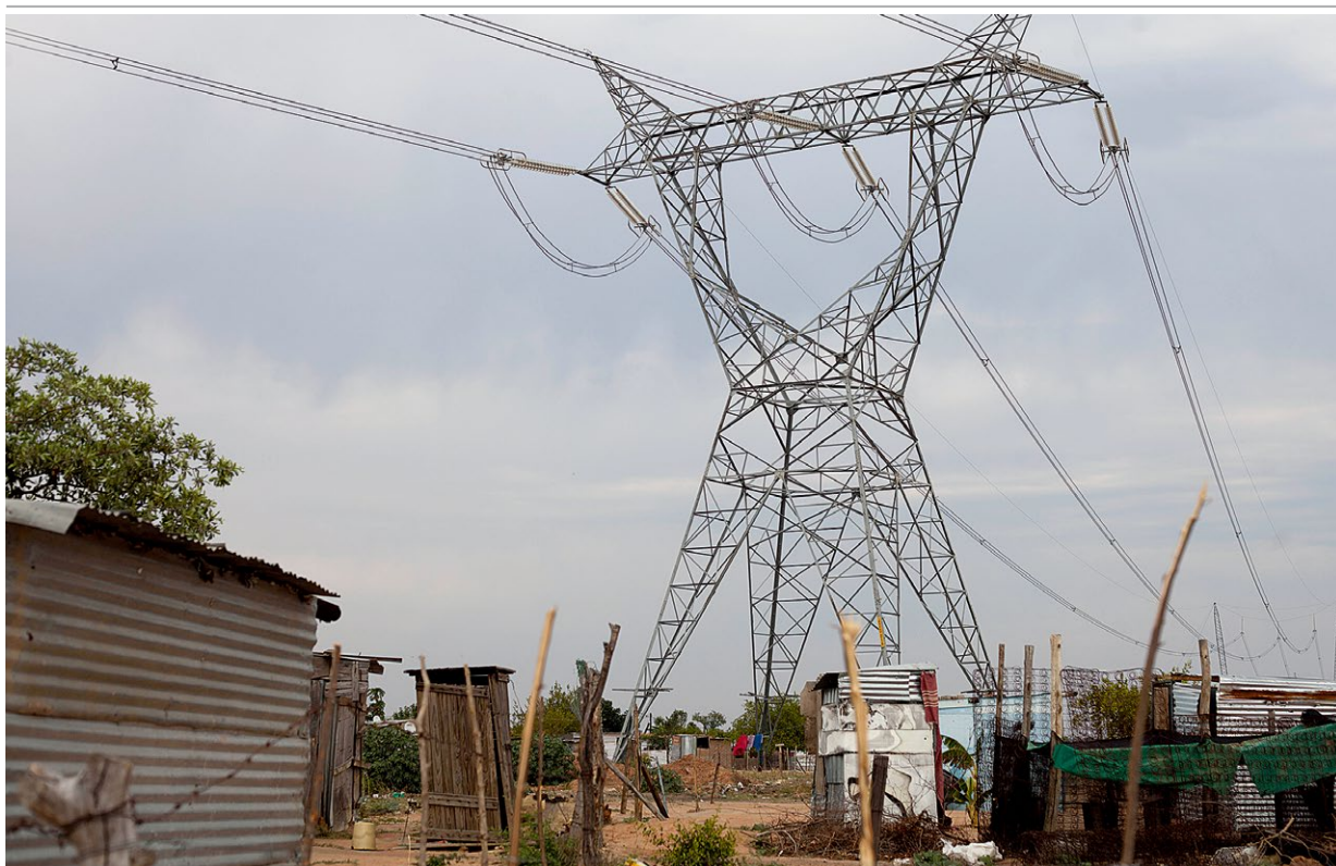
Lange Stromtrassen führen über die Baracken informeller Siedlungen. In der Nachbarschaft liegt das Kraftwerk Medupi, doch nur die wenigsten Menschen in der Region haben Zugang zu Strom.
