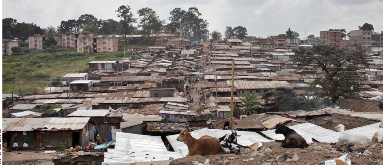
Die Siedlung Mathare im Nordosten von Nairobi, Kenia
